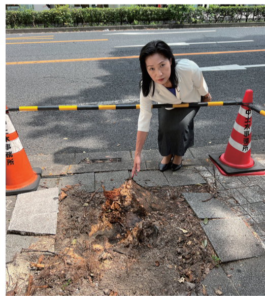
直径約45cm ←の街路樹が倒れた現場
